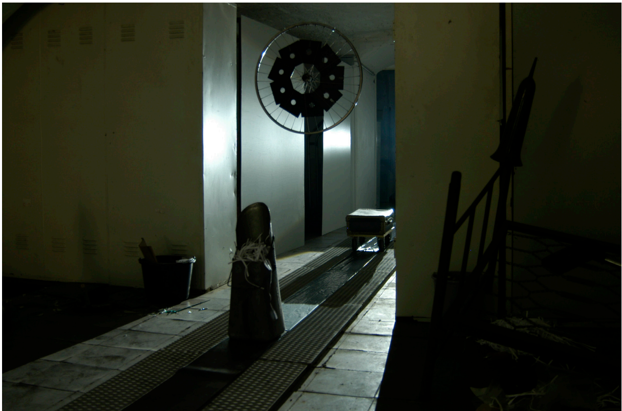
Durchgang verschlossener Bereich
